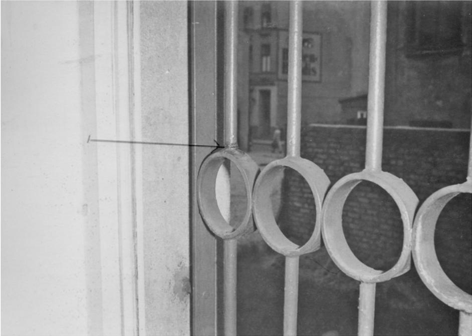
Abb. 12: Ein 20 mm starker Gitterstab wurde 4 mm tief eingesägt, 1963
